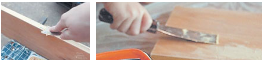
Мал. 142. Процес шпаклювання
