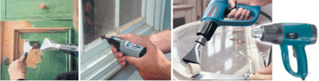
Мал. 231. Очищення дерев'яних конструкцій
