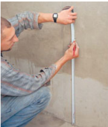
Мал. 244. Намічання місць розташування схованої електропроводки
