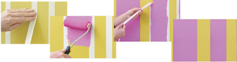
Мал. 222. Технологія фарбування стін смугами
