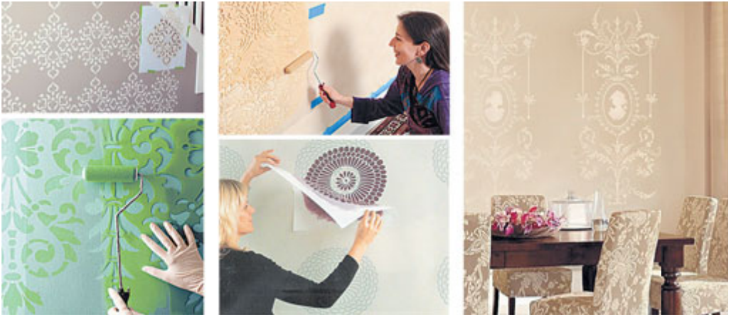
Мал. 228. Нанесення малюнка за допомогою трафарету
