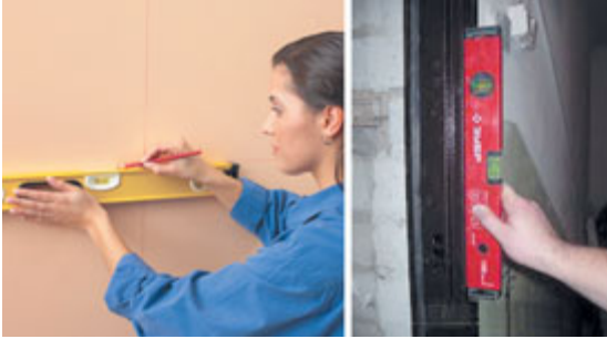
Мал. 254. Розмічання поверхні рівнем; а – горизонтальності; б – вертикальності
