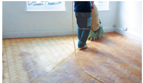
Мал. 86. Прийом циклювання паркету електричною циклювальною машиною
