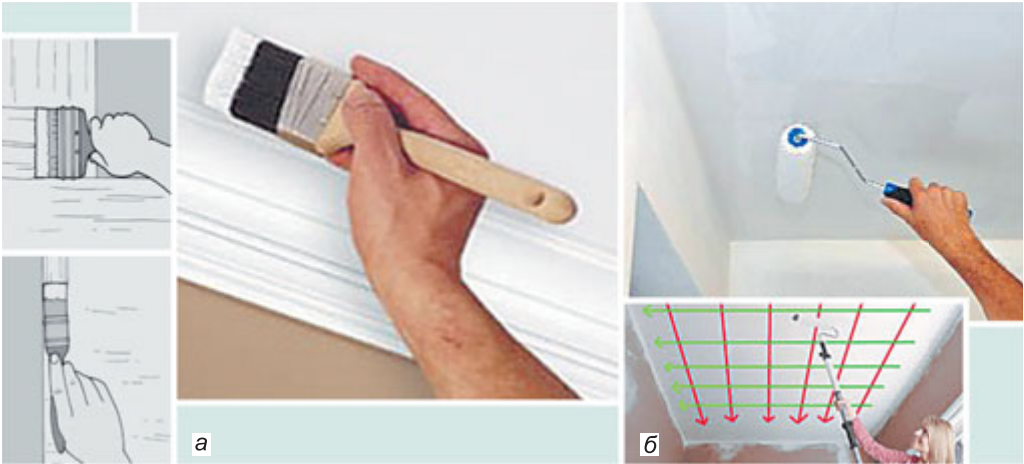
Мал. 220. Послідовність нанесення фарбувальних сумішей: а – флейцем; б – валиком
