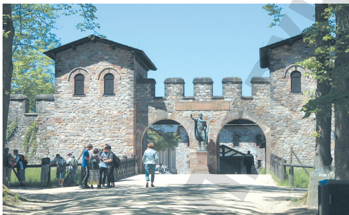
▲ Римське укріплення на окраїні імперії (на території сучасної Німеччини), споруджене наприкінці I ст.
