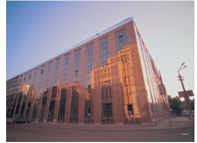
Мал. 234. Перетворення старої швейної фабрики на сучасний бізнес-центр «Fabrika» у Дніпрі
