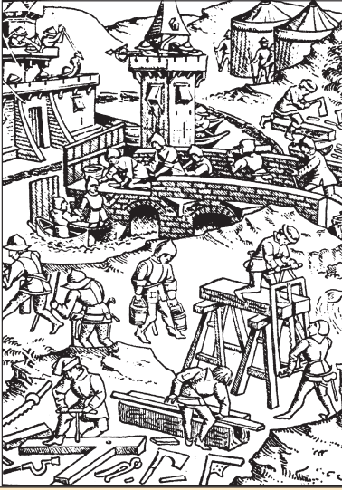
Будівництво кам'яного мосту та дерев'яних укріплень під час облоги міста. Мініатюра. XIV ст.
