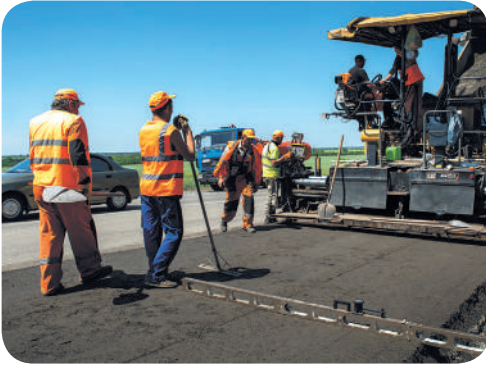
Ремонт дорожнього полотна
