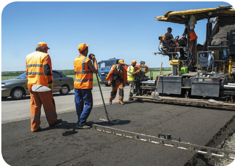
Ремонт дорожнього полотна
