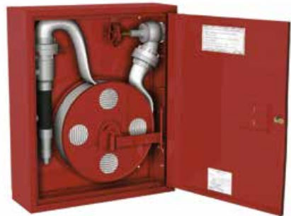
Внутрішній пожежний кран
