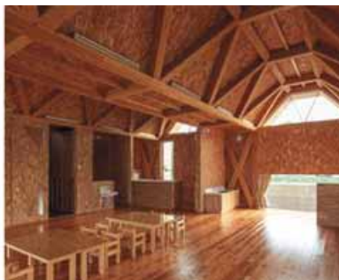
Мал. 25. Застосування ОСП: а – обшивання стін будинку; б – обшивання дахів
