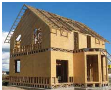
Мал. 25. Застосування ОСП: а – обшивання стін будинку; б – обшивання дахів
