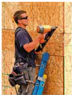
Мал. 25. Застосування ОСП: а – обшивання стін будинку; б – обшивання дахів
